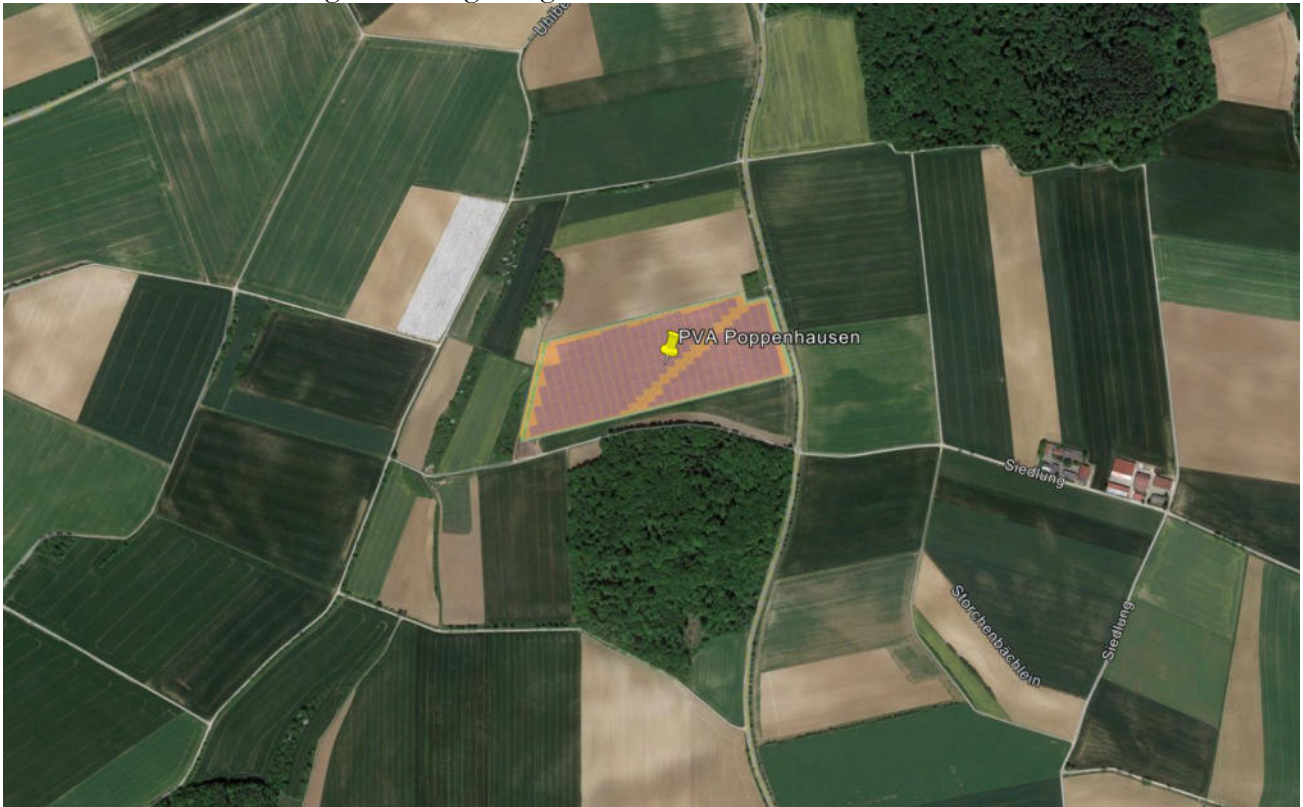
Bild 2.1.2: Detailansicht der PV-Fläche (Quelle: Google Earth/SolPEG)
